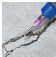
Инъектирование бетона
